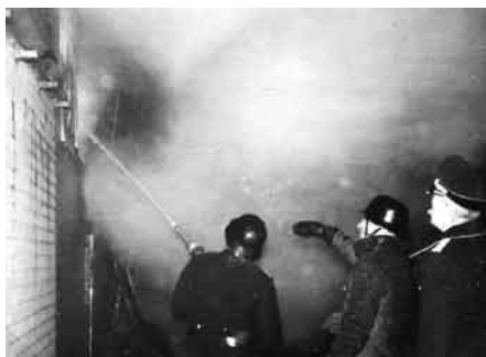
Bei den Löscharbeiten am Wulff Gebäude am 13.01.1963 in Blangenmoor
