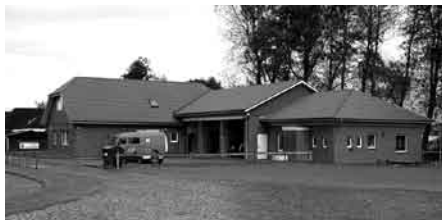
Das Gerätehaus. Seit 2000 mit einem neuen Dach
