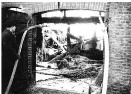
Löscharbeiten am Dohrn Hof in Westerbüttel. Das Gebäude brannte bis auf die Grundmauern nieder.
